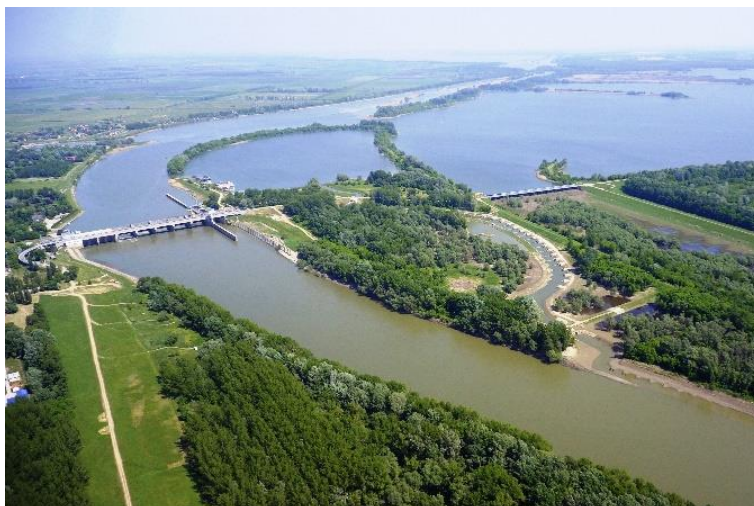
2. kép. A kiskörei létesítményegyüttes (erőmű, vízlépcső, hallépcső, hullámtéri duzzasztó), háttérben a Téli-kikötő és a Tisza-tó abádszalóki öble (Fotó: KÖTIVIZIG)
