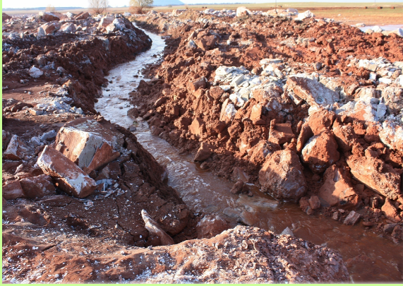
Új vízvezető árokrendszer kiépítése (X. kazetta kiszakadásánál)
